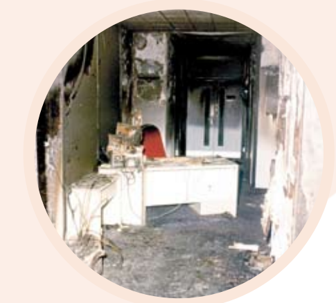
O resultado de um incêndio num escritório
